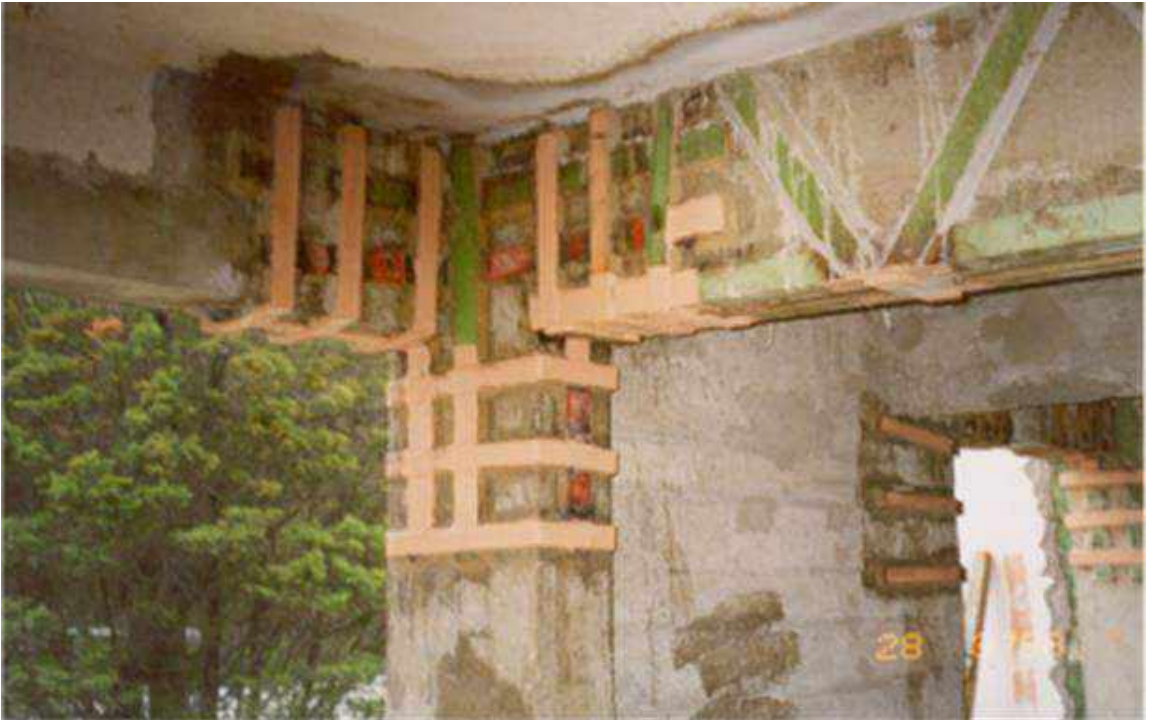
DÜĞÜM NOKTALARINDA İZO-PST® PROCESS SİSTEM UYGULAMASI
