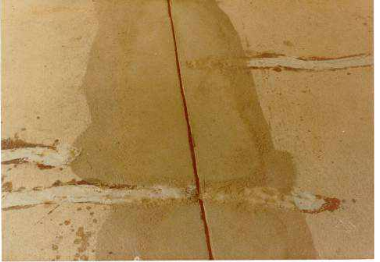
EPOXY ENJEKSİYON VE REPAIR MORTAR İLE PİST ONARIMI
