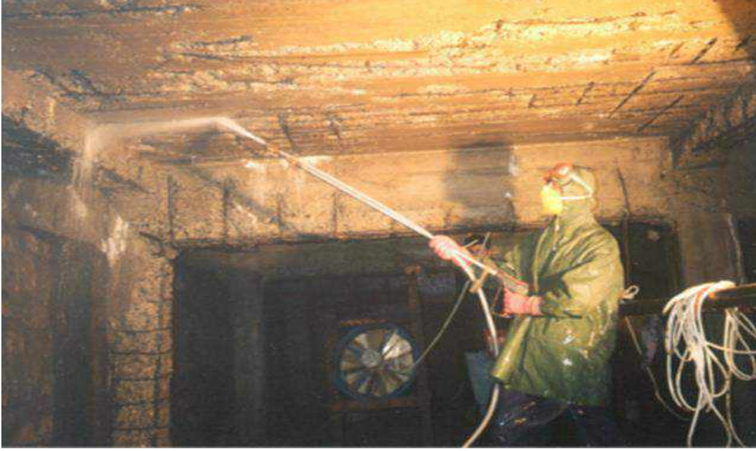
WATER-JET UYGULAMASI İLE ZAYIF BETONUN TEMİZLENMESİ VE KOROZYONA UĞRAMIŞ DONATILARIN KOROZYONDAN ARINDIRILMASI
