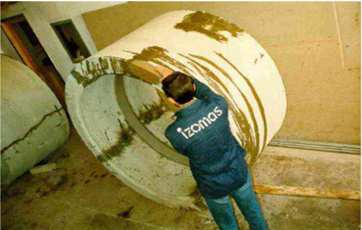
KIRIMI YAPILMIS BORUNUN STATİK TAKVİYE İLE ONARIMI VE GÜÇLENDİRİLMESİ
