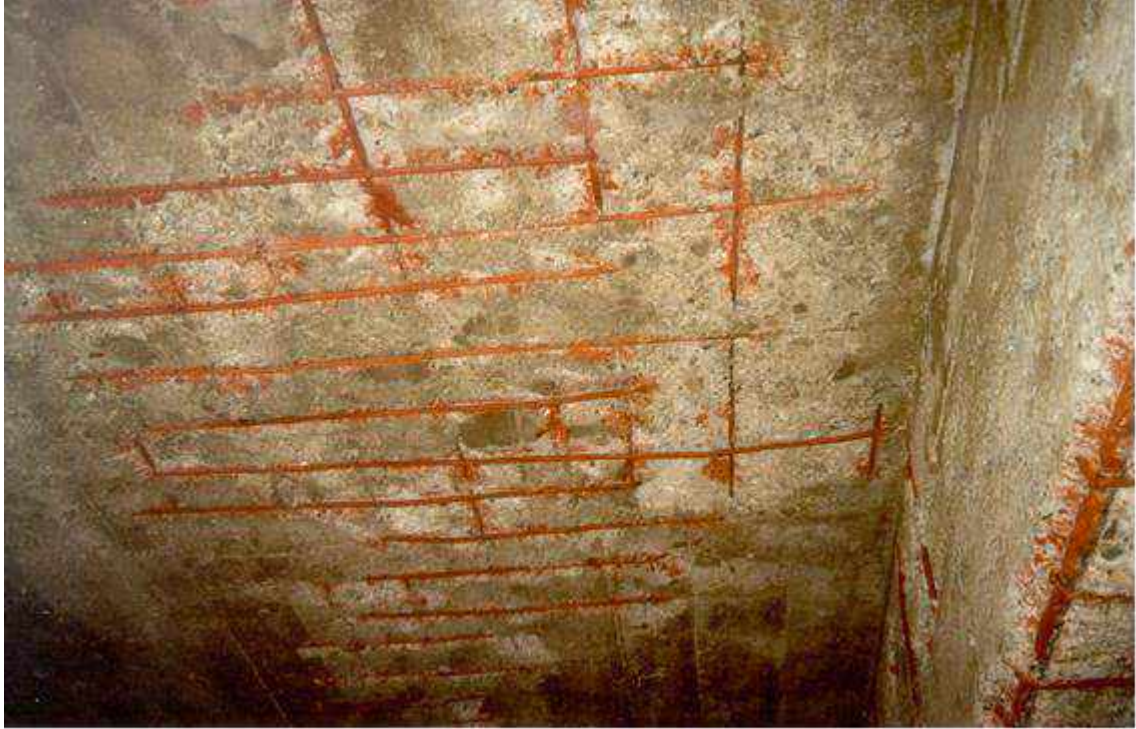
EPOKSİ İLE KAPLANAN DONATILARININ
