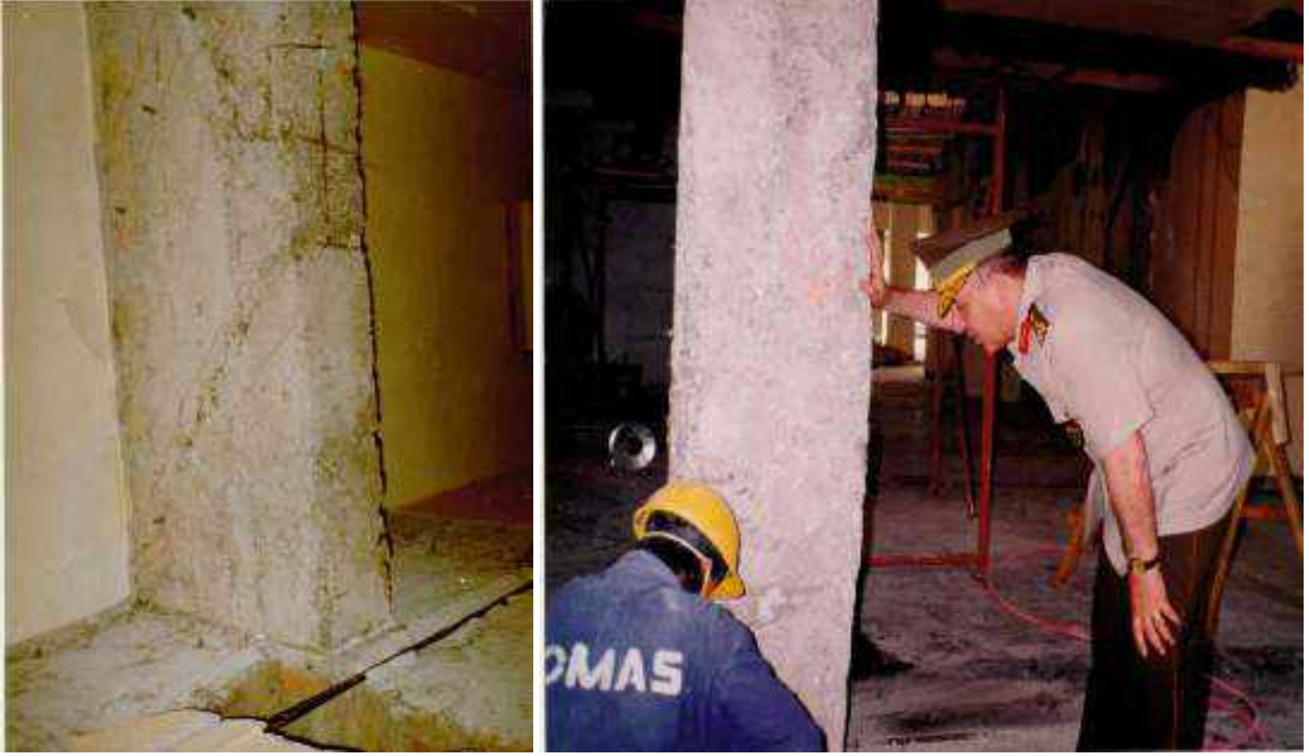
TAŞIYICI ELEMANLARDAKİ ÇATLAKLARIN TESBİTİ VE BU ÇATLAKLARA EPOXY ENJEKSİYON YAPILMASI
