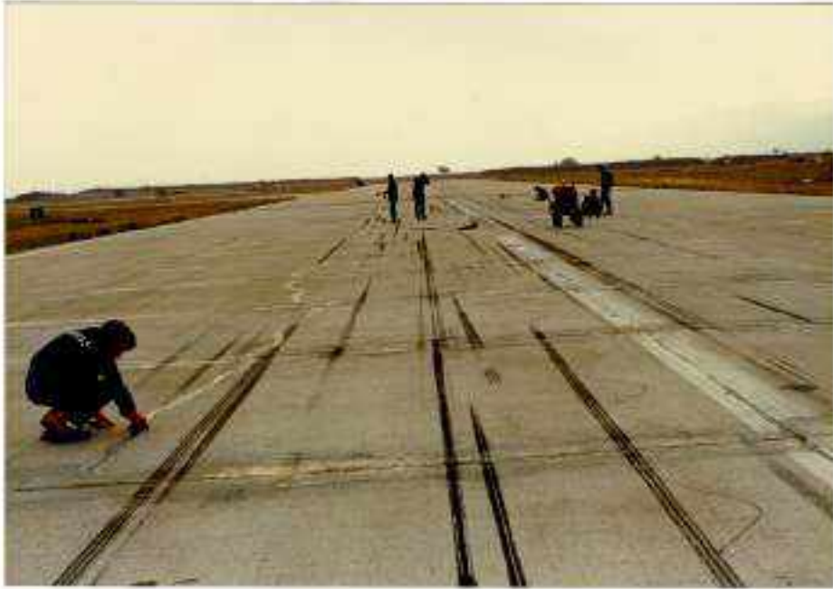
EPOXY ENJEKSİYON VE REPAIR MORTAR İLE PİST ONARIMLARI
