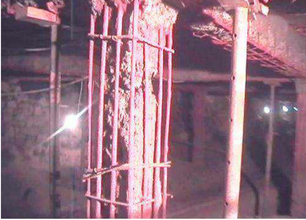
EPOKSİ İLE KAPLANMIŞ 13C KOLONU DONATILARI
