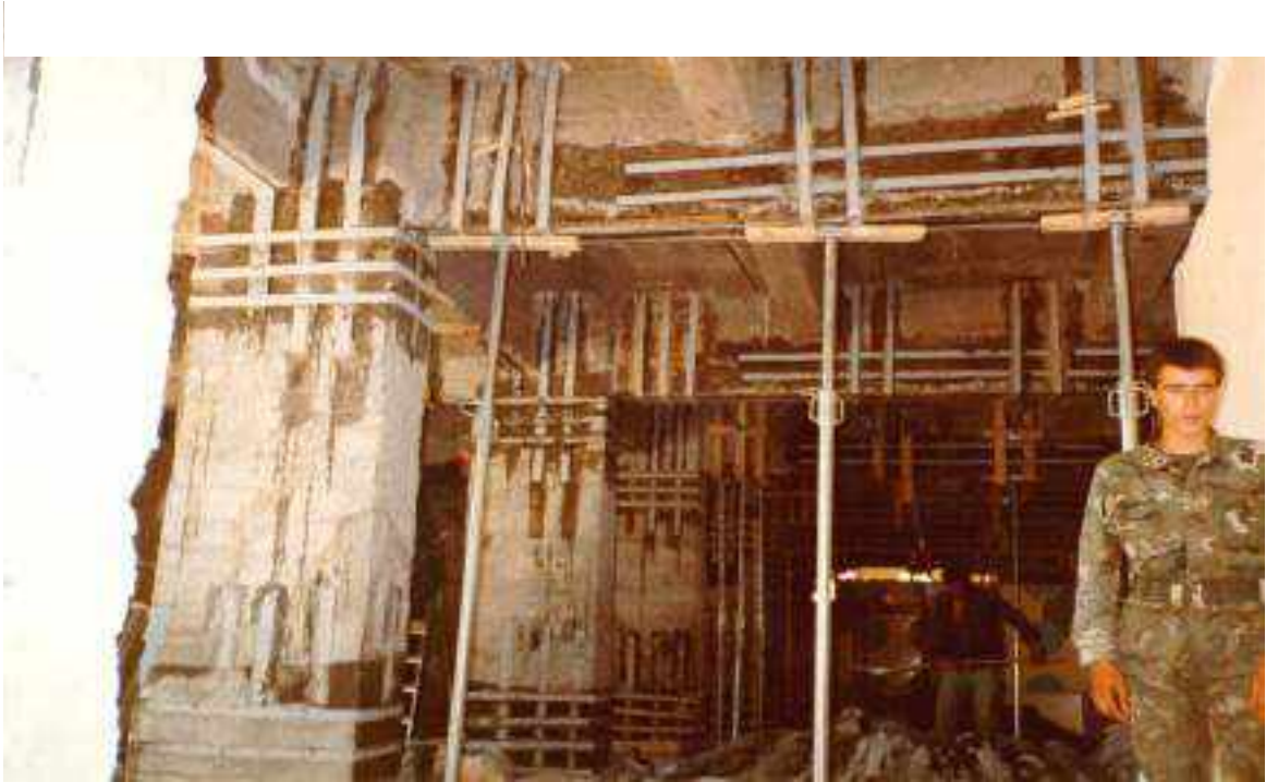
KOLON VE KİRİŞLERİN İZO-PST® PROCESS SİSTEM İLE ONARILIP DEPREME KARŞI GÜVENİLİR HALE GETİRİLMESİ
