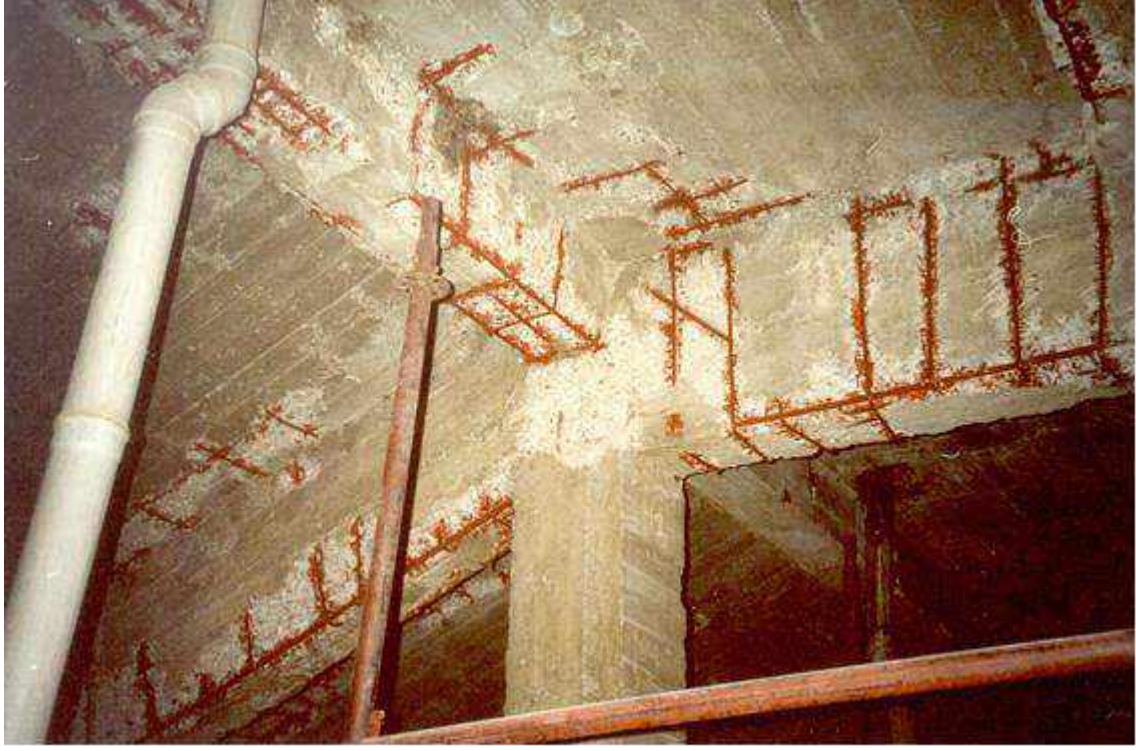
EPOKSİ İLE KAPLANAN DONATILARININ
