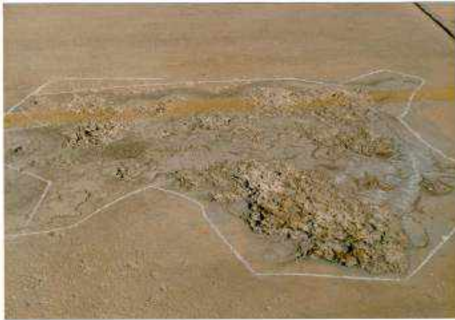
EPOXY ENJEKSİYON VE REPAIR MORTAR İLE PİST ONARIMI
