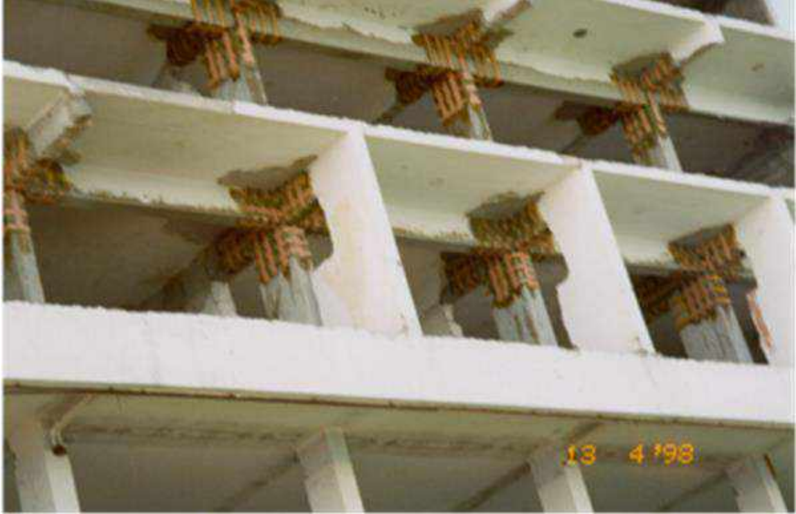
DÜĞÜM NOKTALARINDA İZO-PST® PROCESS SİSTEM UYGULAMASI
