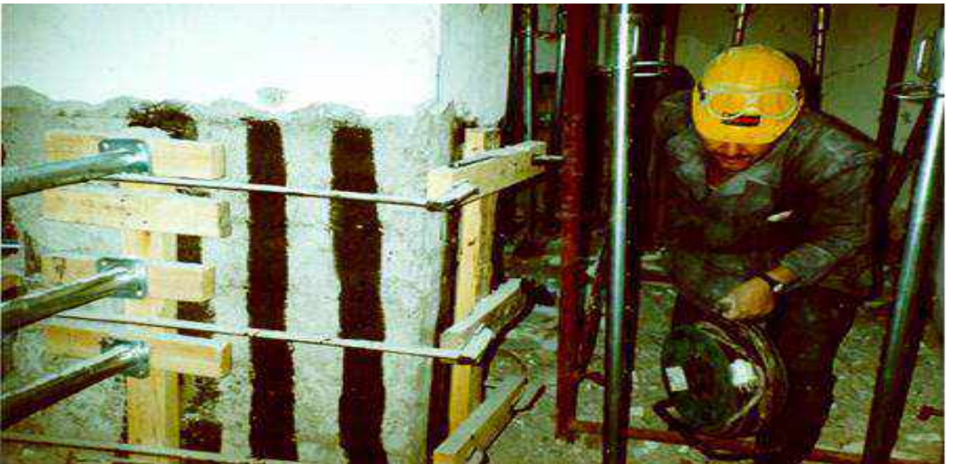
KOLONLARDA DÜĞÜM NOKTALARINDA DONATI YERLEŞTİRİLMESİ VE ÇELİK BANTLARLA ZAAFIYET GİDERİLMESİ
