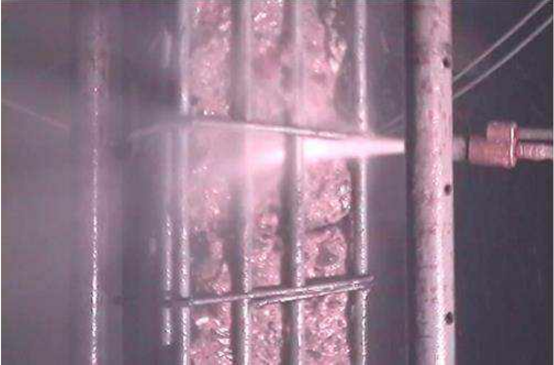
WATER-JET İLE DONATILARIN TEMİZLENMESİ
