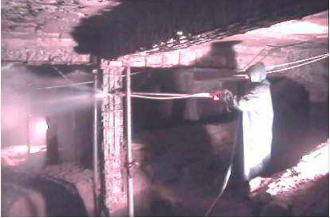
WATER-JET İLE DONATILARIN TEMİZLENMESİ
