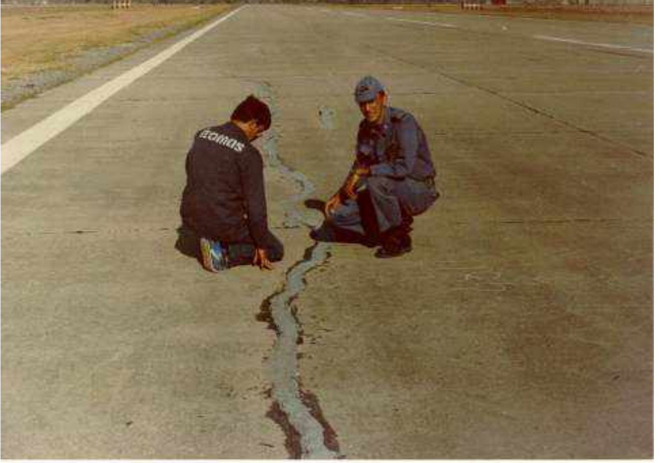
EPOXY ENJEKSİYON VE REPAIR MORTAR İLE PİST ONARIMLARI
