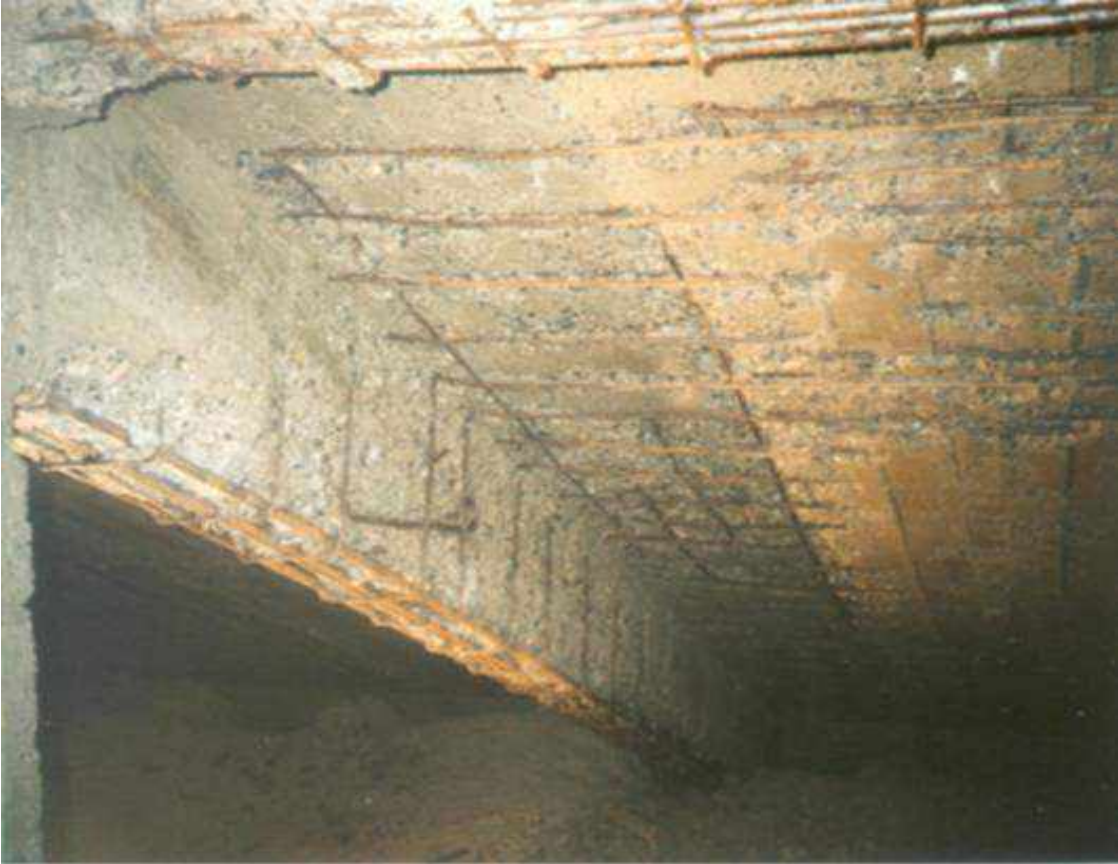
WATER-JET UYGULAMASI İLE ZAYIF BETONUN TEMİZLENMESİ VE KOROZYONA UĞRAMIŞ DONATILARIN KOROZYONDAN ARINDIRILMASI
