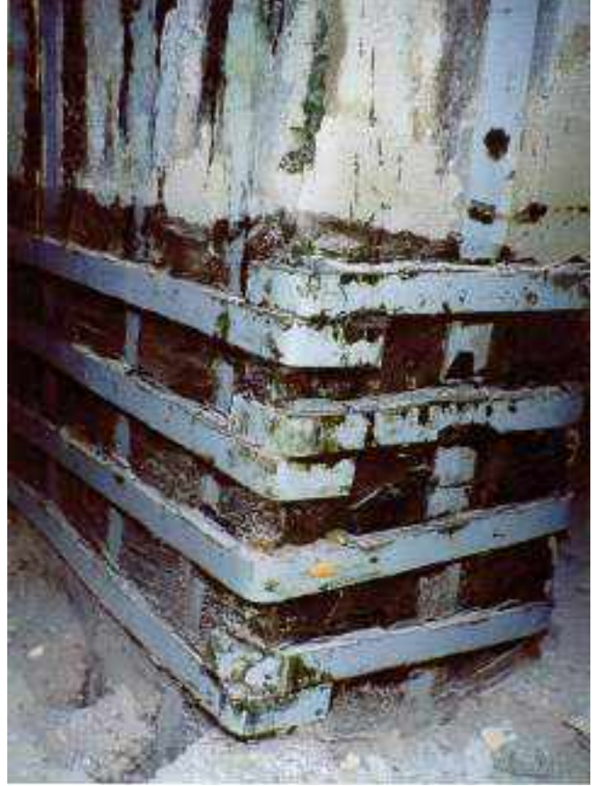
EPOXY ADHESİVE İLE YAPIŞTIRILAN ÇELİK BANTLAR
