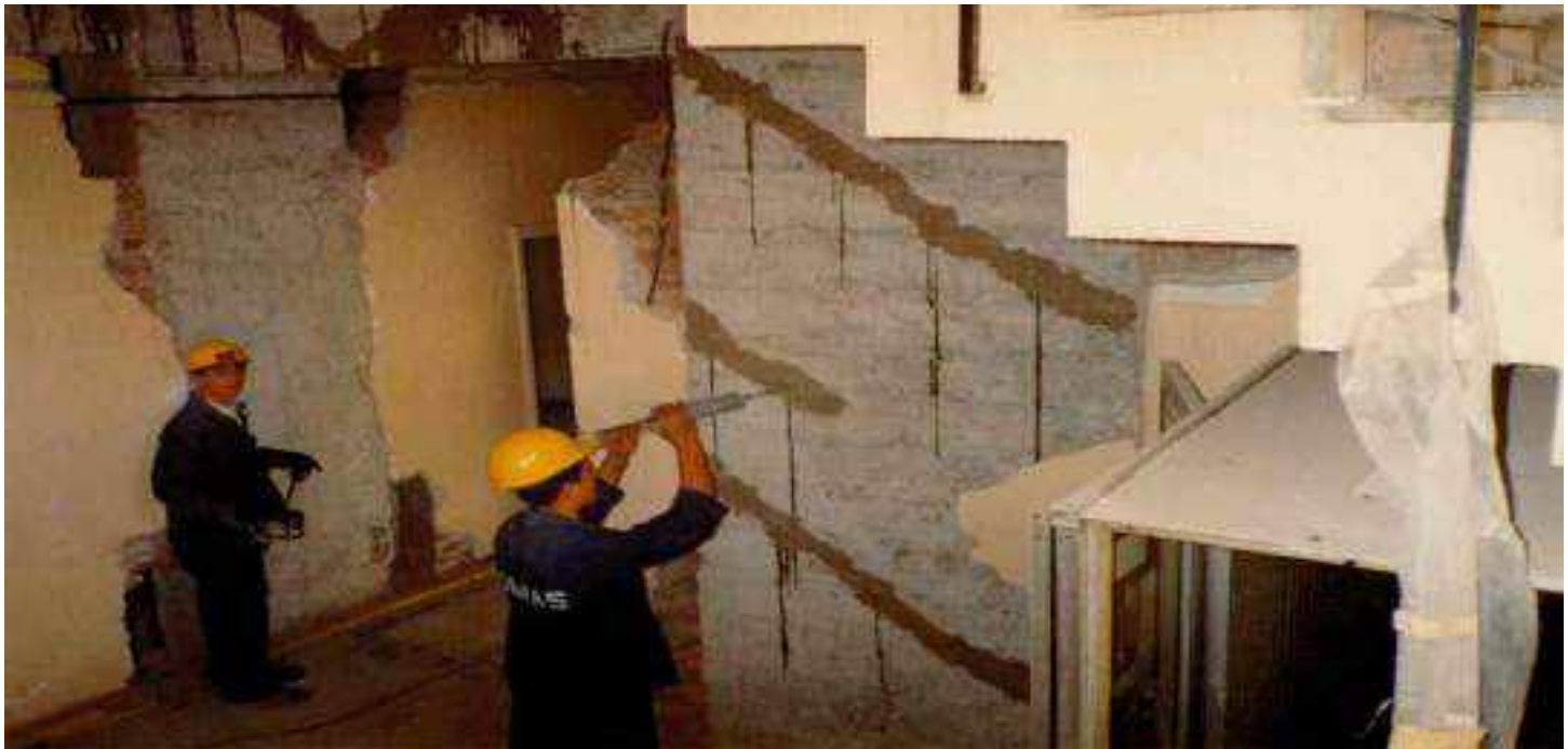
TAŞIYICI ELEMANLARDAKİ ÇATLAKLARIN TESBİTİ VE BU ÇATLAKLARA EPOXY ENJEKSİYON YAPILMASI
