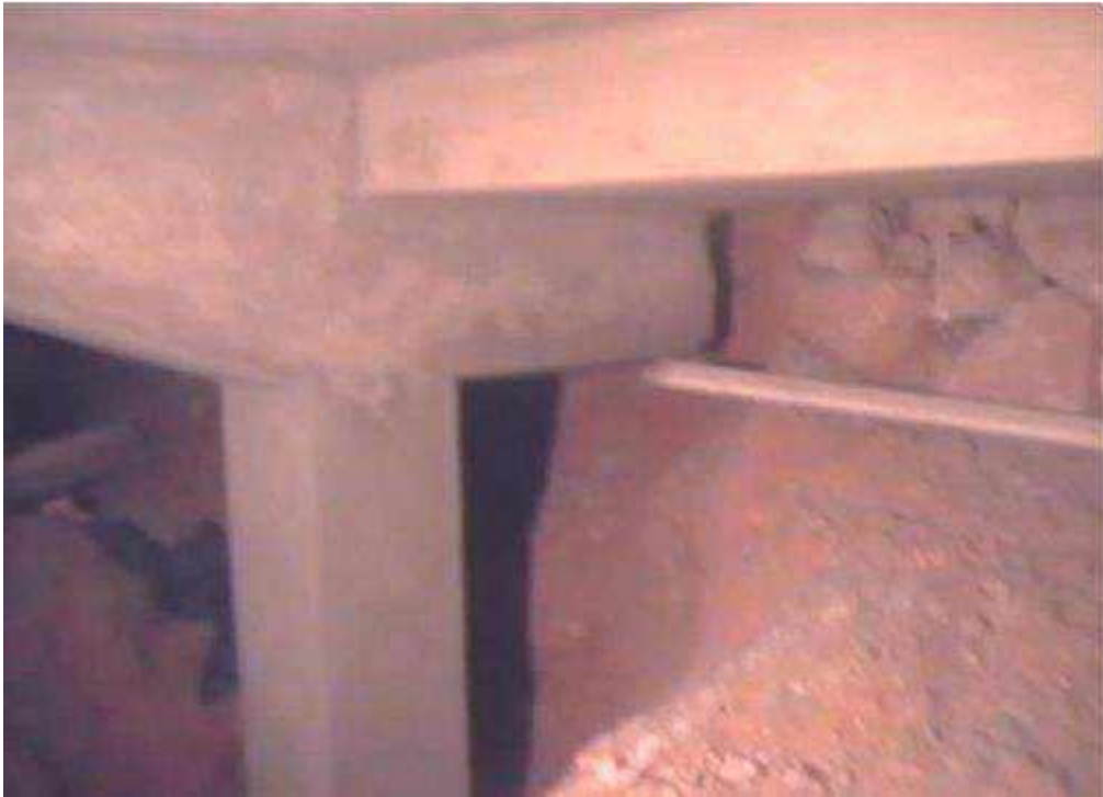
İZOMET-BRM TAMİR HARCİ İLE GEOMETRİSİNE
